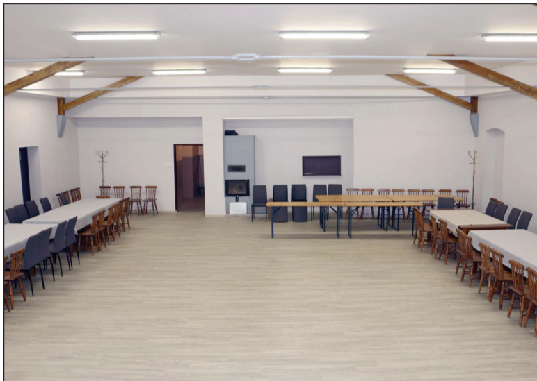
Modernizacja obejmowała roboty budowlane w głównym pomieszczeniu budynku
