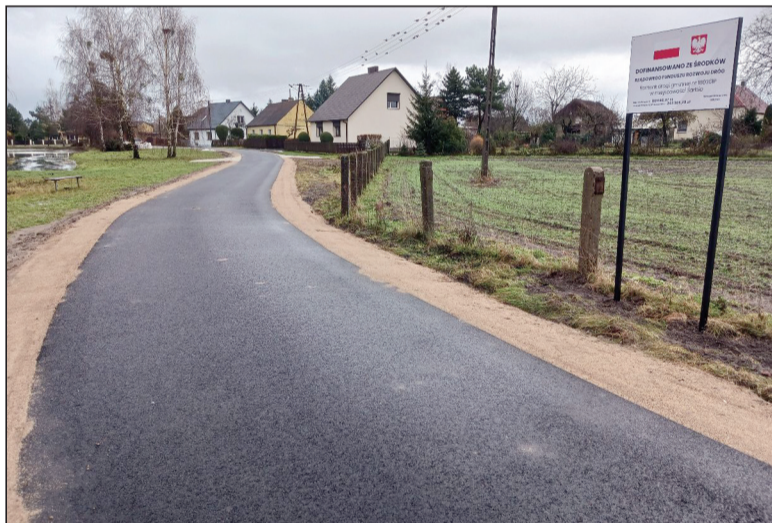
Beton asfaltowy w Sarbi
